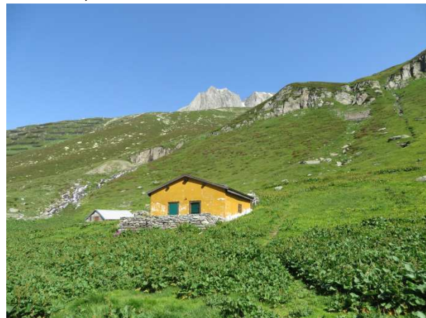
Gebäude, von Blacken umgeben
