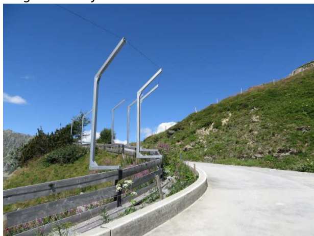
Skipistensicherung am Gütsch
