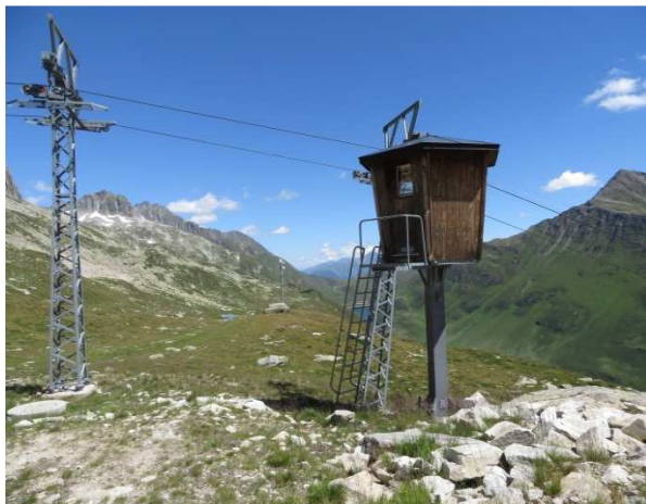
Bergstation Skilift Grossboden, Gütsch
