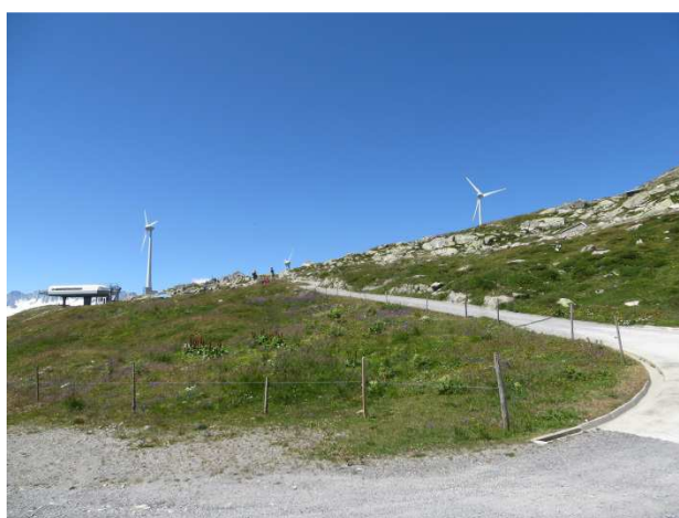
Bergstation auf dem Gütsch
