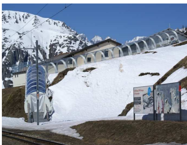
Talstation zum Gütsch beim Bahnhof Nättschen
