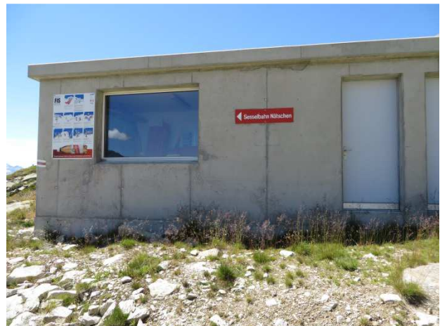
Bergstation Skilift Grossboden, Gütsch
