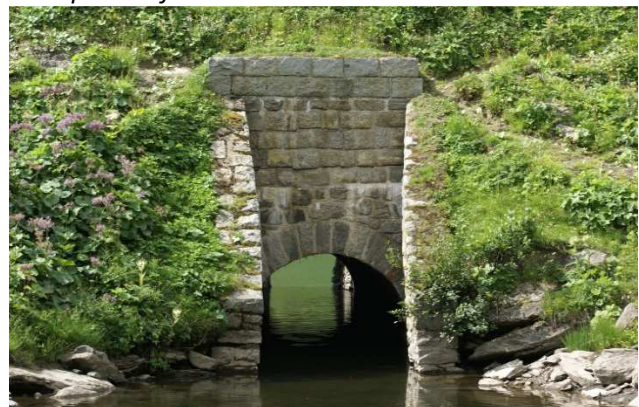
Wasserdurchlass beim Oberalpsee
