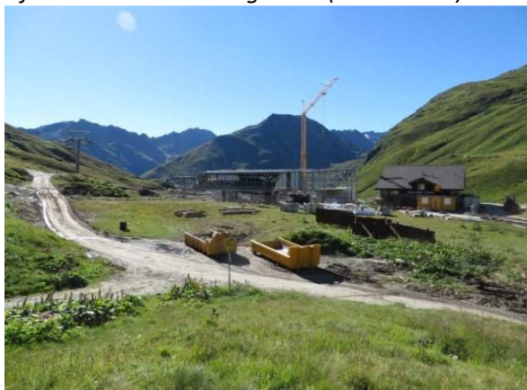
Talstation der neuen Sechsesselbahn im Bau, Oberalp – Calmot (23.08.2016)
