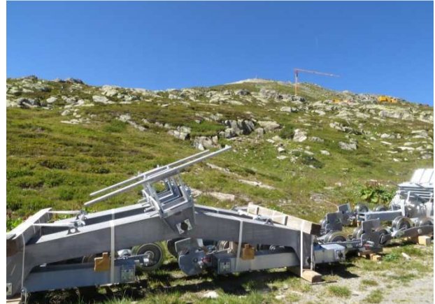
Rollen für die Bergstation der Sechssersesselbahn Unterstafel – Gütsch (23.08.2016)
