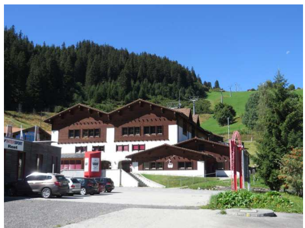
Talstation der Skianlagen Dieni - Milez
