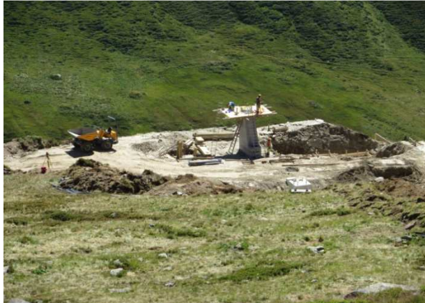
Bau der Talstation Sechssersesselbahn Unterstafel – Gütsch (25.08.2016)
