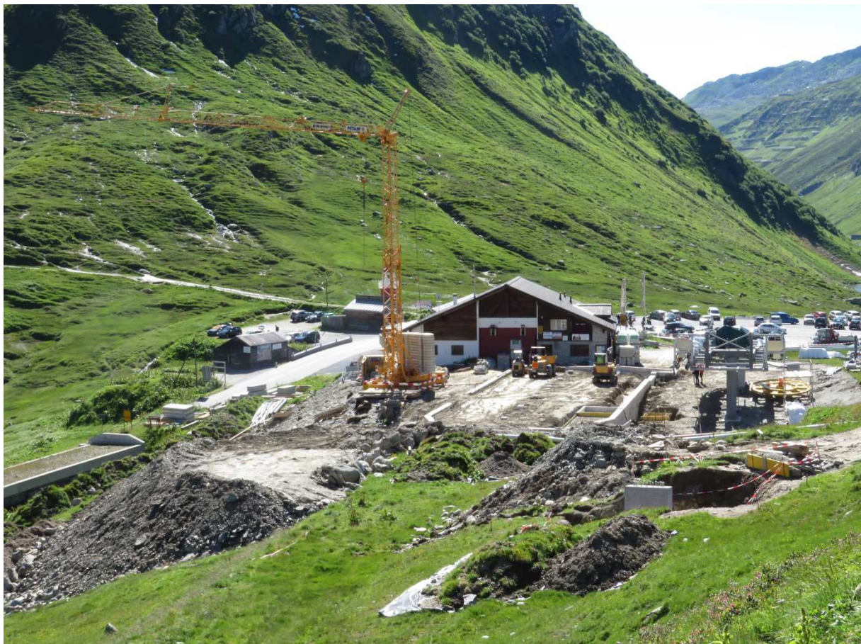
Baustelle Talstation Sessellift Oberalppass – Calmot am 17. Juli 2016
