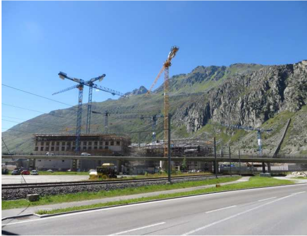
Bau des Resorts (25.08.2016)
