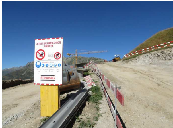
Grossbaustelle Bahnhof Nätschen
