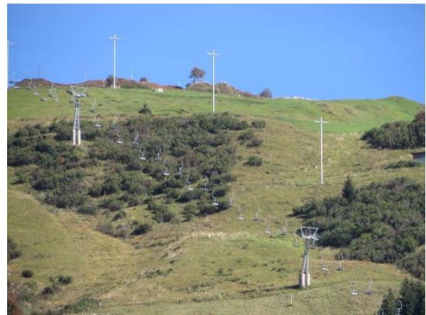
Bestehender alter Sessellift Andermatt – Nätschen im Bereich Grind
