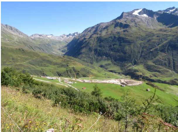
Grossbaustelle Bahnhof Nätschen (23.08.2016)
