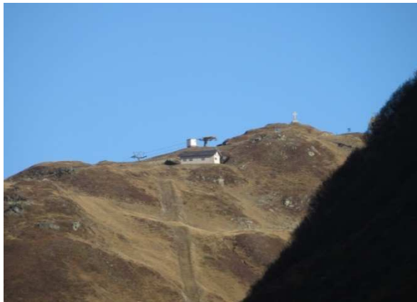
Trasse des alten Skilifts Oberalp – Calmot. Der Lift wurde 2016 zurückgebaut (31.10.2016)
