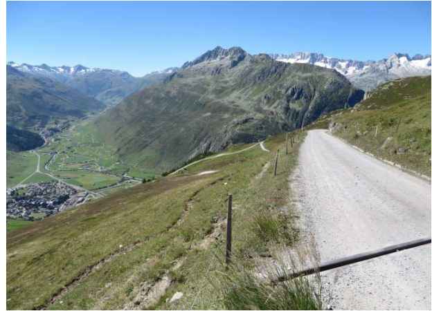
Strasse Gütsch-Nätschen, Blick Richtung Andermatt mit Furkapass, Böz und Dammakette
