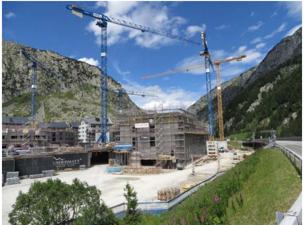
Bau des Resorts (03.08.2016)
