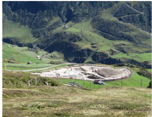
Grossbaustelle der Zwischenstation beim Bahnhof Nättschen (23.08.2016)
