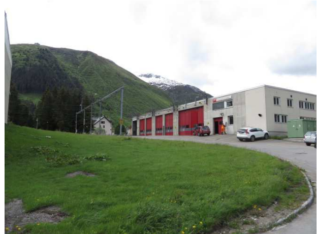
Bestehendes Bahndepot der MGB in Andermatt
