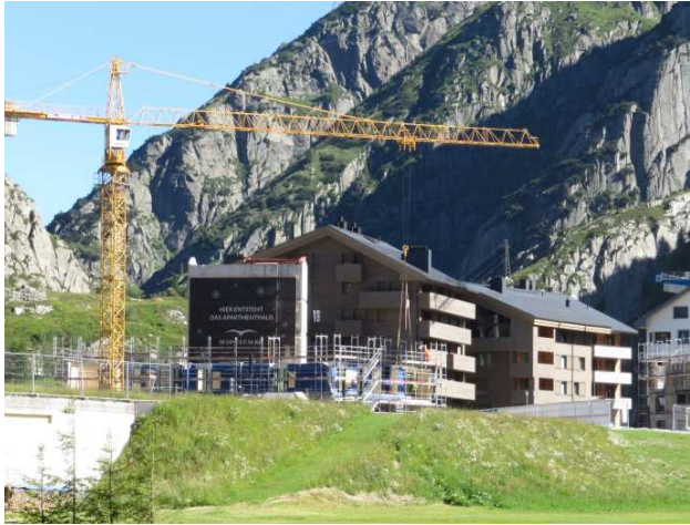
Bau des Resorts (19.07.2016)
