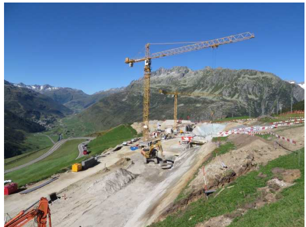
Erdarbeiten beim Bahnhof Nätschen (25.08.2016)
