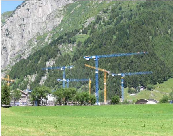
Bau des Resorts (19.07.2016)
