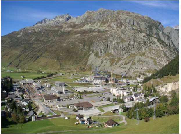
Bau des Resorts (29.09.2016)
