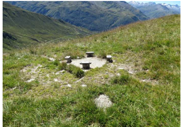
Verankerungen für die Liftstützen bei Unterstafel
