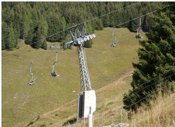
Bestehender Sessellift Andermatt – Nätschen. Er wird 2017 durch eine Gondelbahn ersetzt werden
