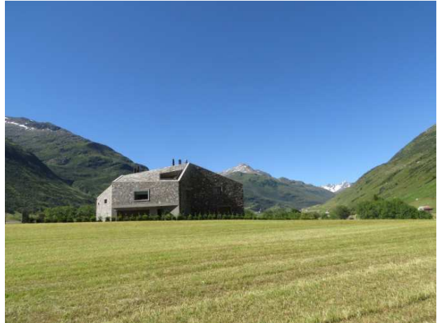
Villa am Nordostrand des Golfplatzes
