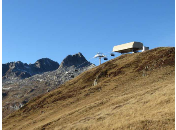
Neue Bergstation der Sesselbahn Oberalp – Calmot (31.10.2016)
