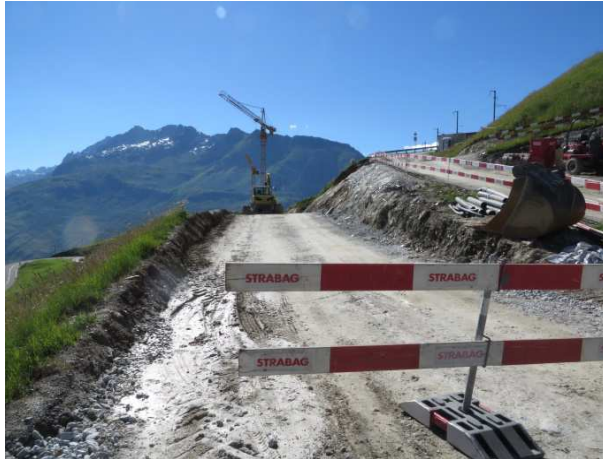
Baustellenzufahrt beim Bahnhof Nättschen
