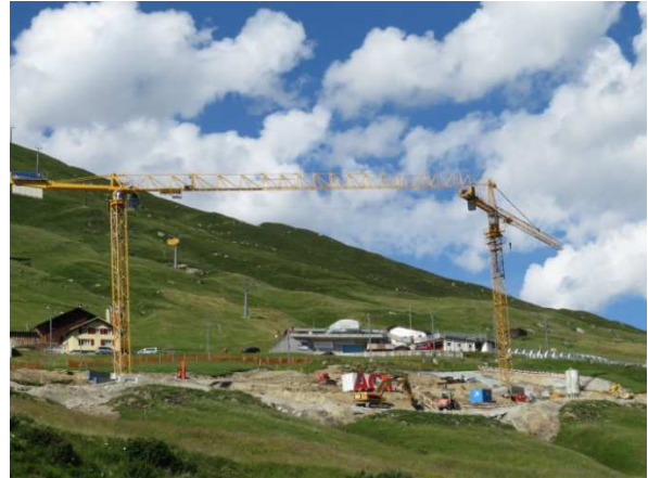
Baustelle Plattform und Bergstation Nättschen (18.07.2016)
