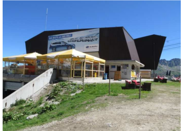
Gemsstock-Luftseilbahnmittelstation mit einem Restaurant als Drehpunkt auf dem Gurschen
