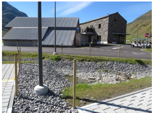
Sickermulde beim Club House Parkplatz
