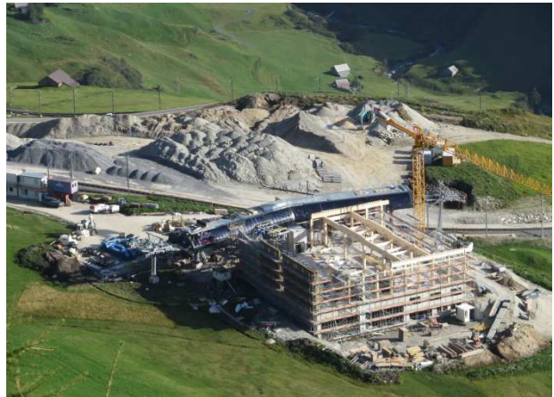
Bei der Mittelstation Nättschen entsteht auch ein neues Restaurant
