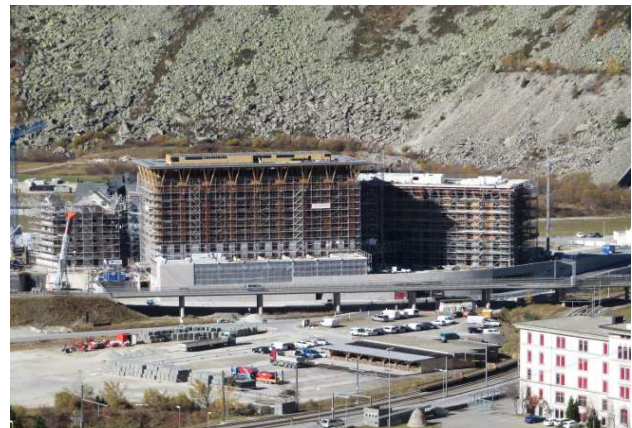
Am 18.10.17 ist die Dachkonstruktion montiert
