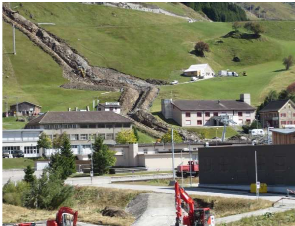
Leitungsbau Andermatt – Nätschen
