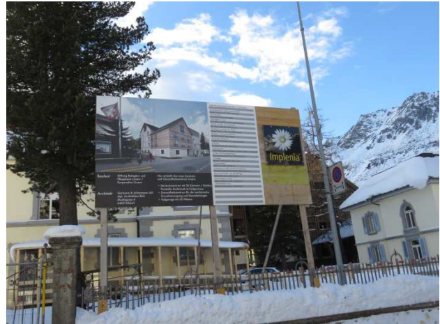
Hier entsteht das neue Senioren- und Gesundheitszentrum Ursern
