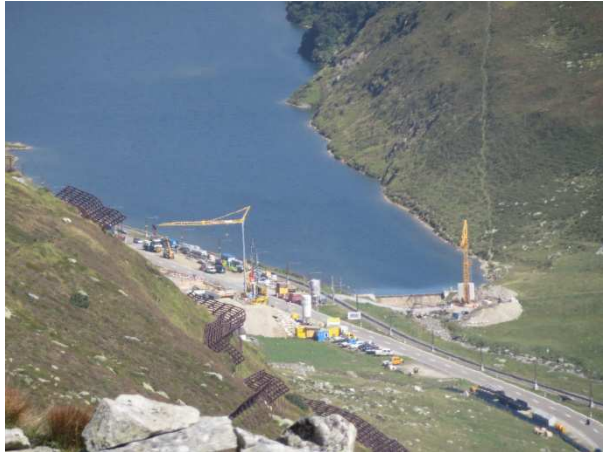
Bau der Pumpstation am Oberalpsee
