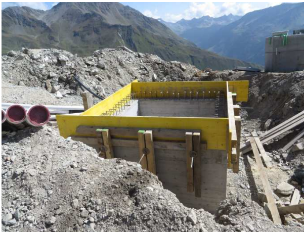
Betonieren eines Sockels im Gebirge
