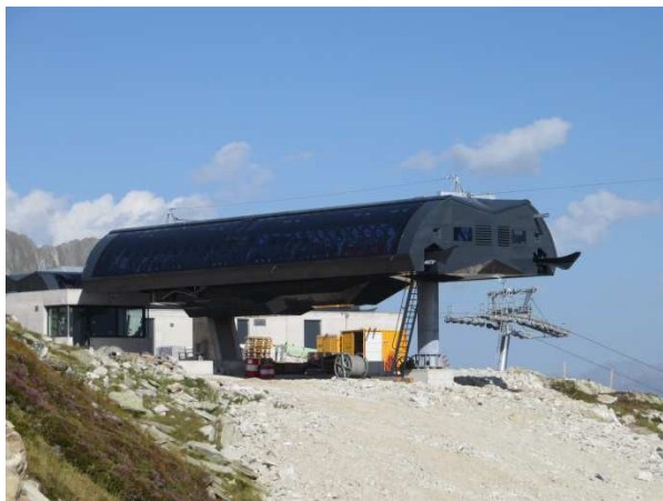
Bergstation Sesselbahn Unterstafel – Gütsch
