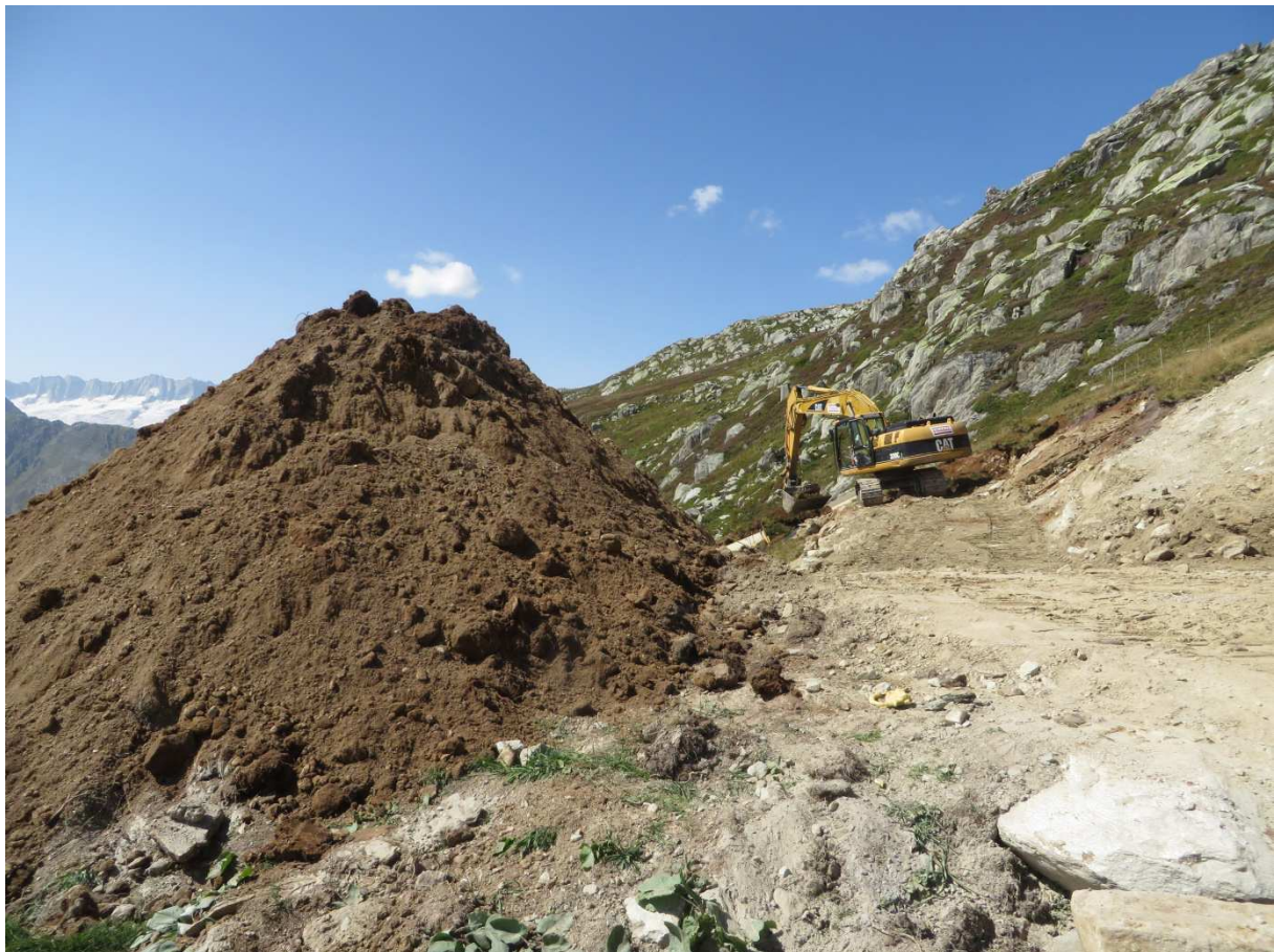
Pistenbau Nätschen – Gütsch am 26. August 2017
