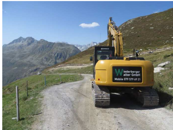
Bagger und Transporter auf der Gütschstrasse
