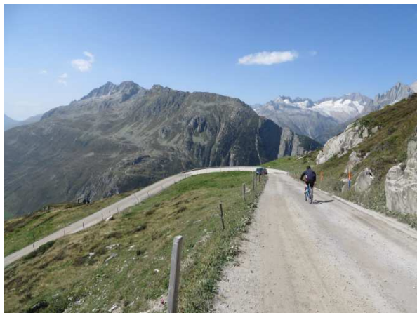
Militärstrasse Nätschen - Gütsch
