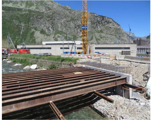
Beim Bahnhof wird eine neue Brücke über die Unteralpreuss erstellt
