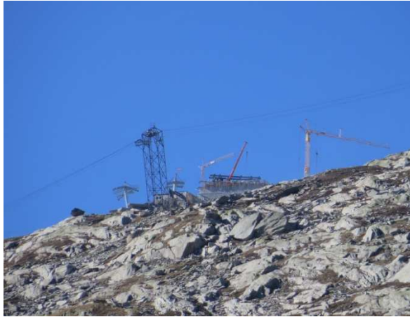
Bau der Bergstation Schneehüenerstock
