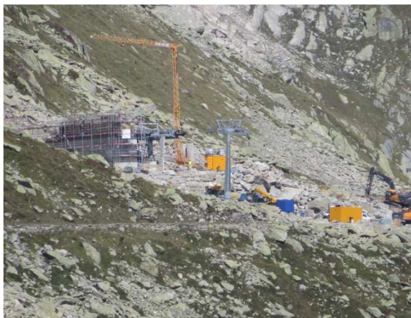
Bau der Bergstation Strahlwand
