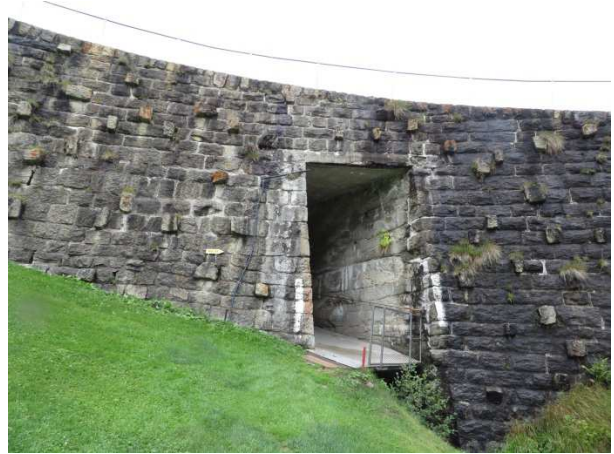
Die Unterführung verbindet den südlichen mit dem nördlichen Golfplatzterrain
