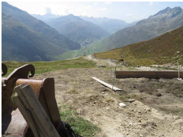
Erdarbeiten für die Piste Nätschen – Gütsch
