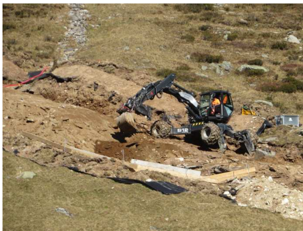
Baumaschinen zum Verlegen der Wasserleitungen
