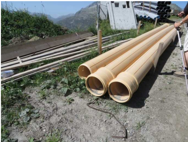
Rohrleitungen und Eisenträger
