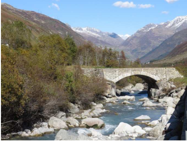
Steinerne Bogenbrücke über die Furkareuss
