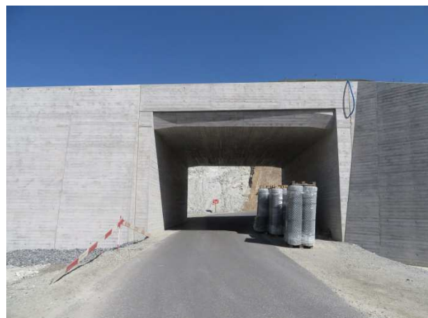
Neue Unterführung Nätschen für die Strasse auf den Gütsch und für die Skipiste
