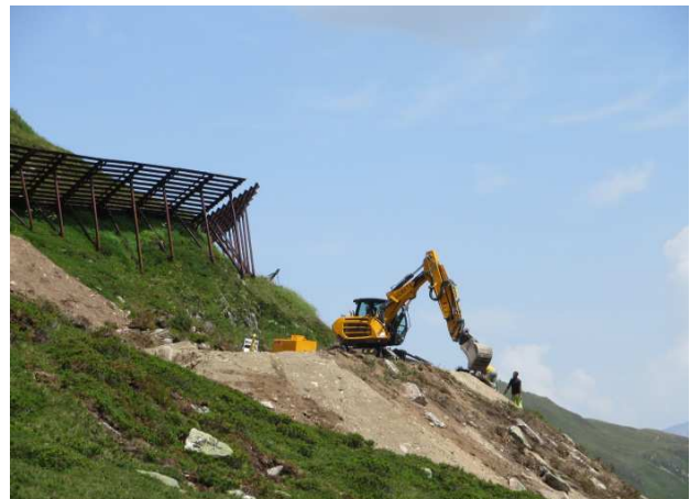
Bau der Talstation Vordere Felli
