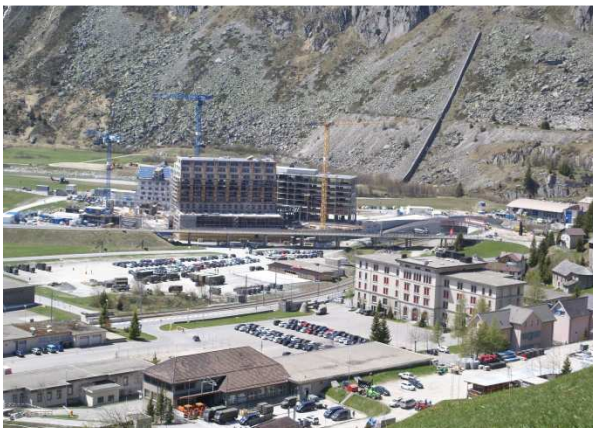
Das Radisson Blu im Rohbau am 16.5.2017
