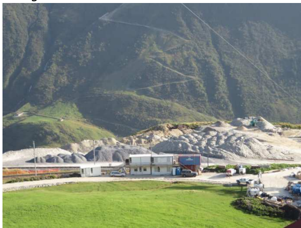
Container und Erdhügel auf der Baustelle
