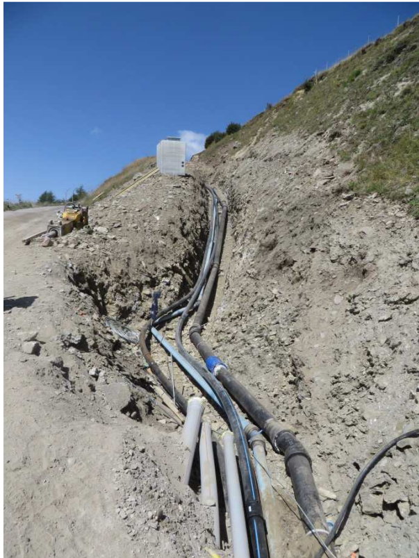
Offene Gräben und diverse Leitungen
