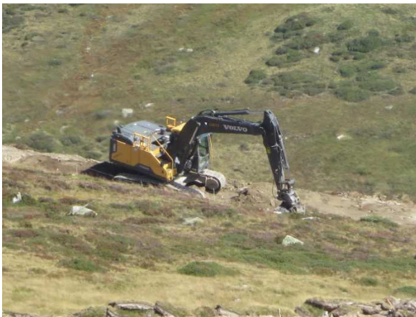
Leitungen werden verlegt
