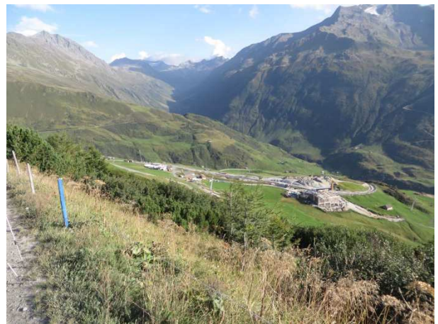
Überblick auf die neuen Bahnanlagen auf dem Nättschen
