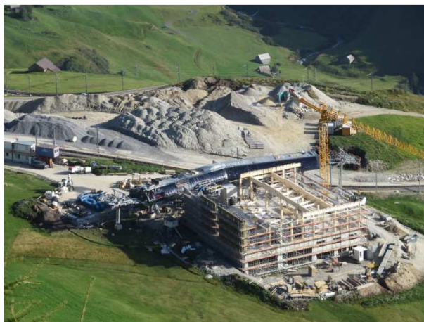
Mittelstation der Gondelbahn im Bau
