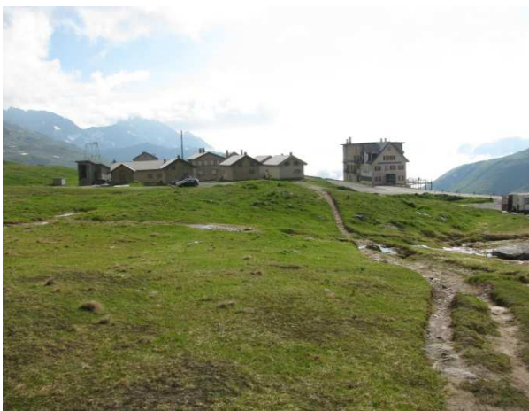
Die Militärgebäude mit dem ALPFOR auf dem Furkapass
