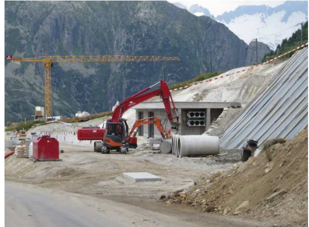
Baustelle Bahnhof Nätschen
