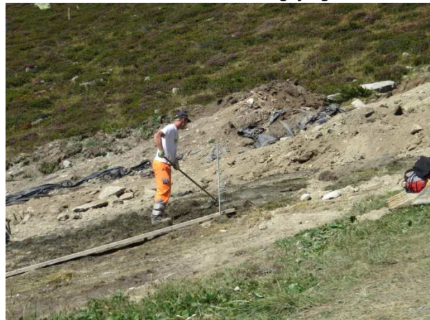
Abgetragene Grasmatten werden wieder verlegt
