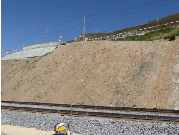
Die Bahngleise auf dem Nättschen wurden neu verlegt
