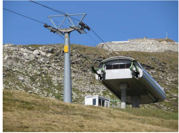
Bergstation Stöckli unterhalb des historischen militärischen Forts
