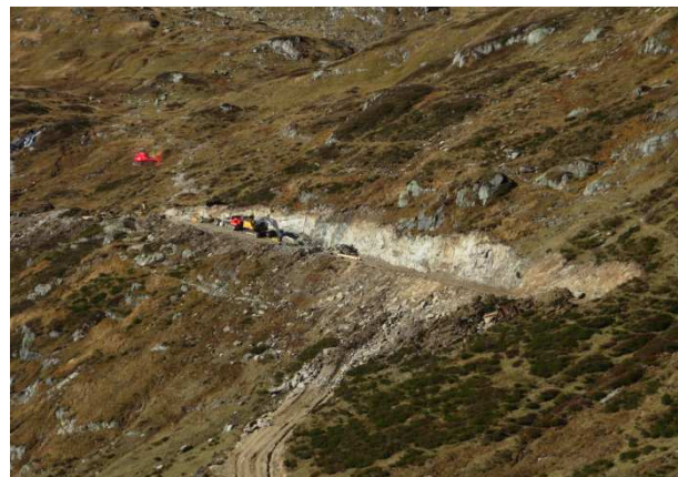
Pistenbau in der Hinteren Felli
