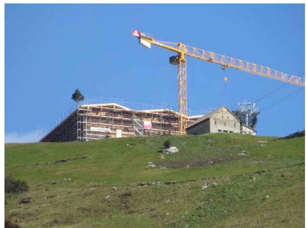
Neues Restaurant beim Bahnhof Nätschen
