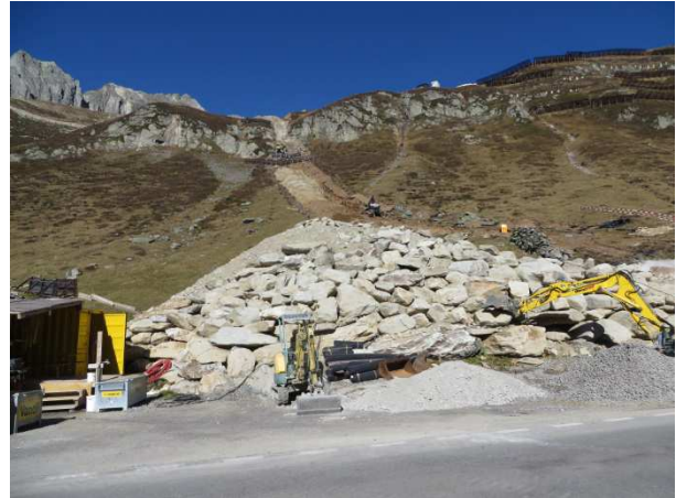
Pumpstation und Wasserleitungen
