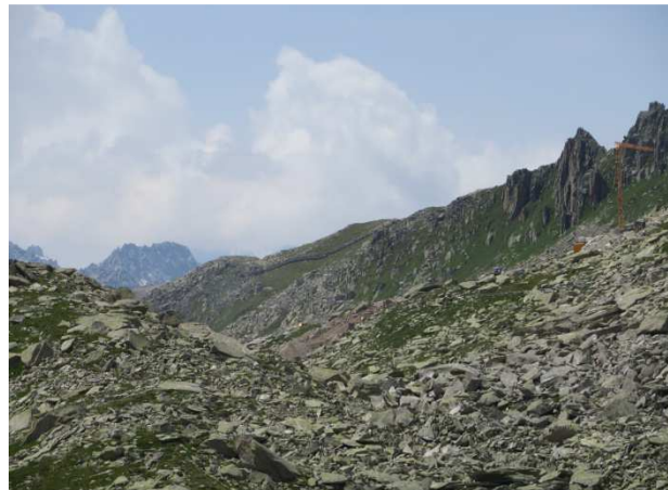
Bergstation Strahlgand in Entstehung, Blick nach Westen
