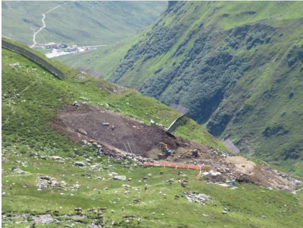
Baubeginn der Gondelbahnanlage am 19.07.17
