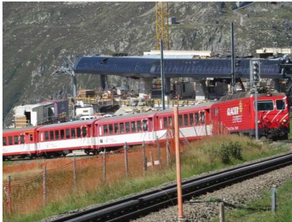
Neue Mittelstation der Achtergondelbahn beim Bahnhof Nättschen
