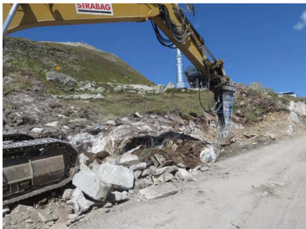
Baumaschine unterhalb dem Stöckli im Einsatz
