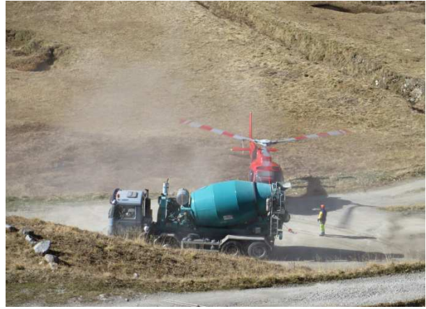
Betonmischer auf dem Oberalppass. Der Beton wird in Kübeln in die Hintere Felli geflogen
