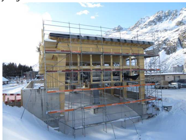
Bau der neuen Talstation Andermatt - Nättschen
