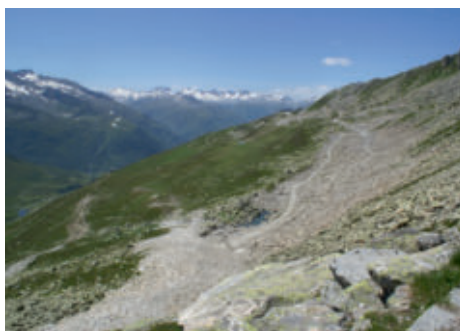
Gütsch und Strahlgang nach dem Bau der Pisten am 20. Juli 2021.
