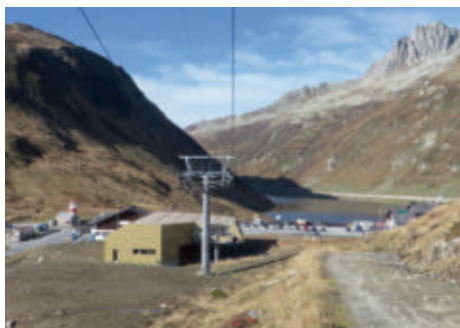
Talstation des neuen Sessellifts Oberalp – Calmut am 27. Oktober 2019.
