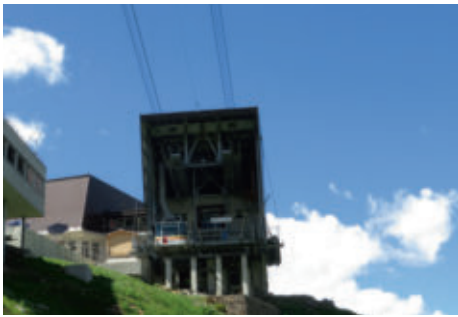
Mittelstation Gurschen der Luftseilbahn auf dem Gemsstock, obere Sektion.
