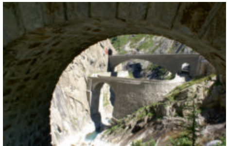
Alte Brücke für den Langsamverkehr und neue Brücke für Autos über die Teufelschlucht.
