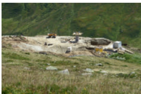
Bau der neuen Lifтанlage Unterstafel auf dem Grossboden.
