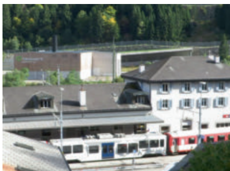
Bahnhofgebäude Göschenen mit Gleisen der MGB und dem Holzheizwerk der Gotthard AG.
