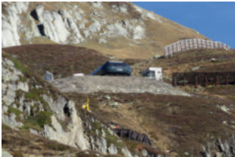
Landschaftseingriffe für das Erstellen der Talstation Vorder Felli – Schneehüenerstock.
