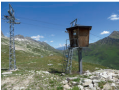
Bergstation des ehemaligen Skilifts vom Grossboden zum Gütsch.
