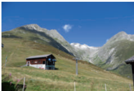
Bergstation des Milez-Flyers, Sesselbahn von Dieni nach Milez.
