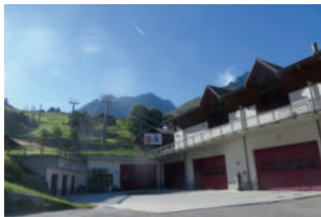
Talstation des Milez-Flyers bei der MGB-Station Dieni und an der Oberalppassstrasse .
