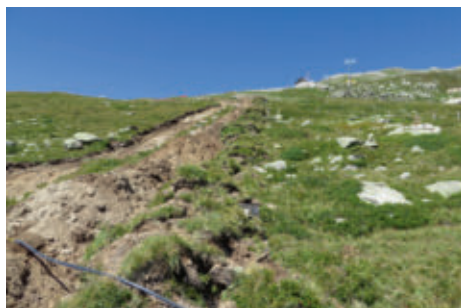
Bau der Wasserleitung für die Beschneigungsanlage der Piste Unterstafel – Gütsch.
