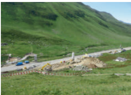
Bau der Pumpstation an der Oberalpstrasse.
