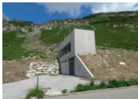
Pumpstation für die Beschneieungsanlagen beim Oberalpsee.
