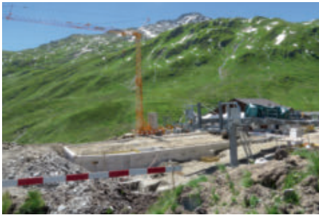
Baustelle für die Talstation der Gondelbahn Schneehüenerstock-Express.
