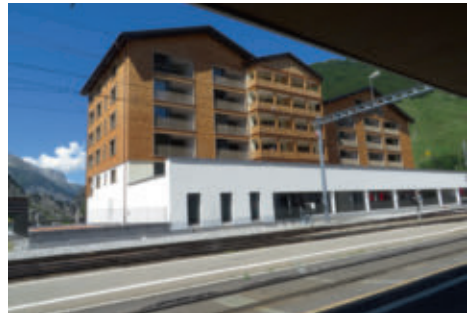
Auf der Nordseite des Bahnhofs Andermatt entstand ein neuer Gebäudekomplex.
