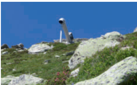
Sprengrohr einer ferngesteuerten Lawinensprenganlage.
