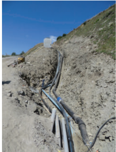
Leitungen für Strom, Trinkwasser und Beschneigungsanlagen am Gütsch werden verlegt.
