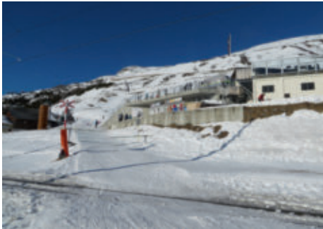
Unbewachter Bahnübergang beim Bahnhof Nättschen am 26. Januar 2017.
