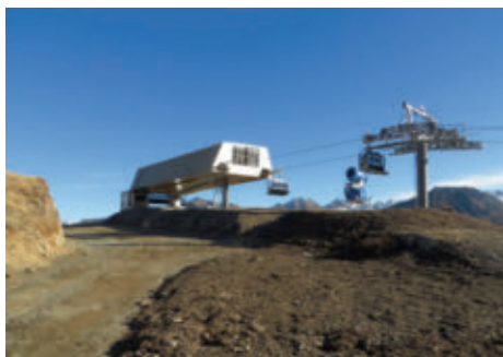
Bergstation des neuen Sessellifts von der Oberalp zum Piz Calmut am 31. Oktober 2016.
