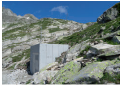
Betriebsstation an der Piste in der Region Lutersee.
