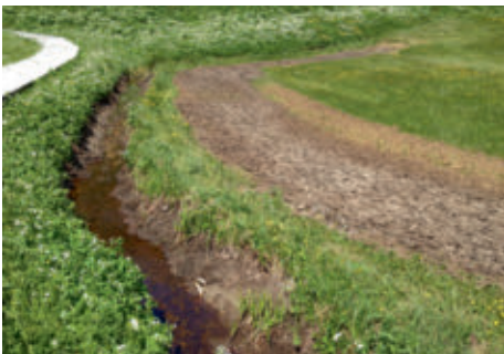
Entwässerungsgraben zwischen Oberem und Unterem Böz. (Foto Martin Käch, 2015)
