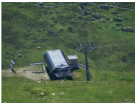
Talstation der heutigen 6er-Sesselbahn Unterstafel – Gütsch (Gütsch-Flyer).
