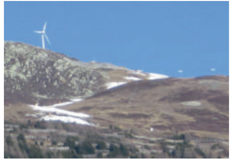
Snow-Farming unterhalb des Windparks entlang der Pisten am Gütsch.
