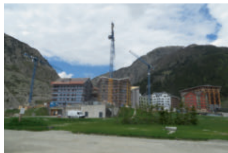
Baustelle Andermatt Reuss am 3.06.2021.
