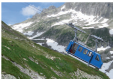
Militärische Seilbahn vom Oberalppass zum Schneehüenerstock.
