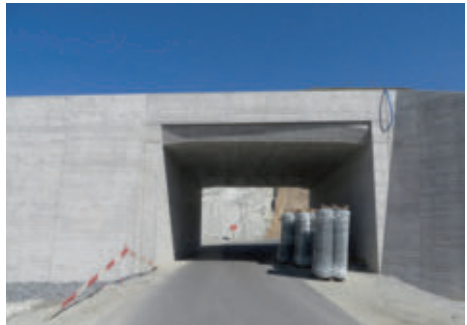
Unterführung beim Bahnhof Nättschen am 29. August 2017.
