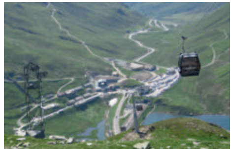
Oberalppass mit Militärseilbahn (links) und Gondelbahn von Platte aus gesehen.
