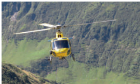
Ein Helikopter startet auf dem Nätchen als Transportmittel für den Bau von Lifтанlagen.
