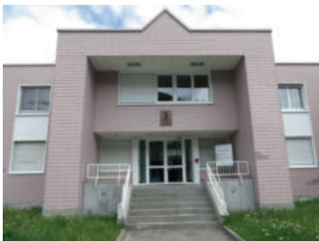
Militärisches Kommandogebäude in Andermatt.
