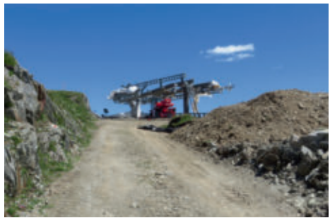
Errichten der neuen Bergstion des Oberalp- Flyers auf dem Piz Calmot.
