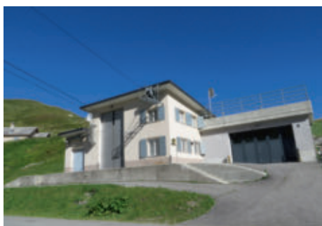
Talstation der militärischen Seilbahn zum Schneehüenerstock vor dem Bau des Express.
