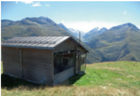
Talstation des Skilifts Tegia Gronda.
