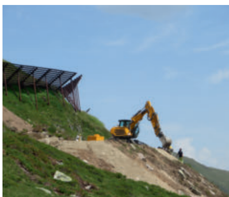
Baustelle zwischen Lawinenverbauungen in der Vorder Felli.
