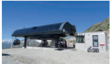
Bergstation der Gondelbahn Gütsch-Express auf einer Höhe von 2367 m ü. M.
