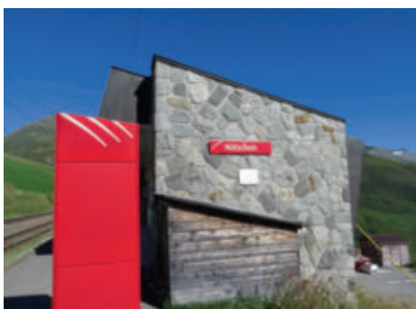
Der alte Bahnhof Nätschen wurde abgerissen.
