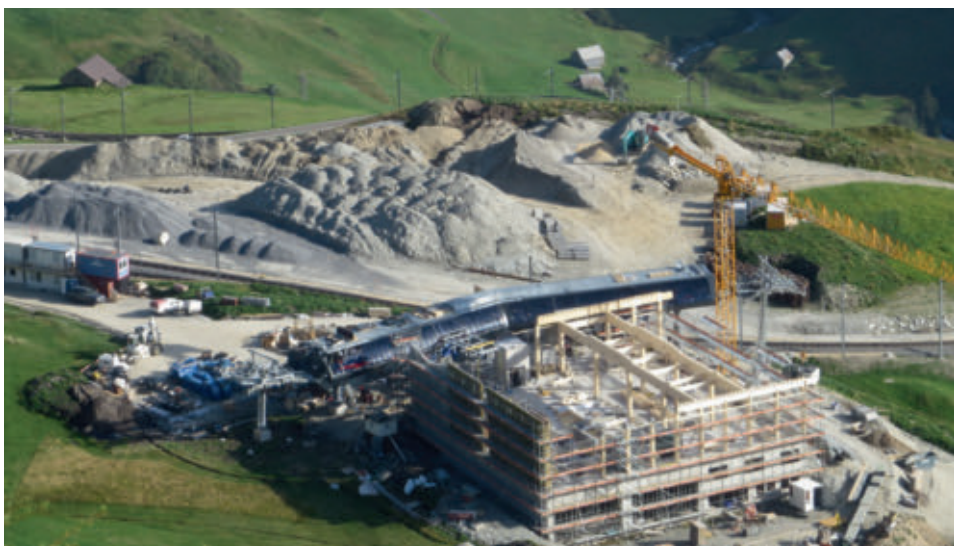
Grossbaustelle im August 2017 für Eisenbahn, Gondelbahn und Restaurant am Nätschen.
