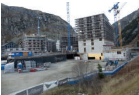
Baustelle Andermatt Reuss am 31.10.2016.
