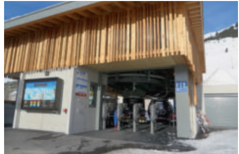
Talstation der neuen Achtergondelbahn Gütsch-Express 1. Sektion in Andermatt.
