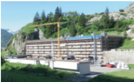
Die sogenannte Kriegskaserne Bühl in Andermatt aus dem Jahr 1888, Renovation 2021.
