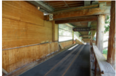
Die Bobschlitten rollen auf Schienen den „Hang“ hinunter und pendeln wieder zurück.
