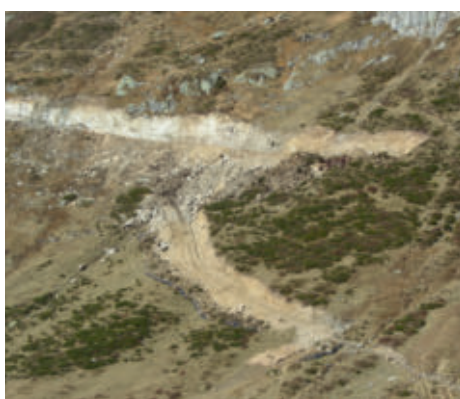
Traverse Hinter Felli, Schneise für die Skipiste Schneehüenerstock – Oberalppass.
