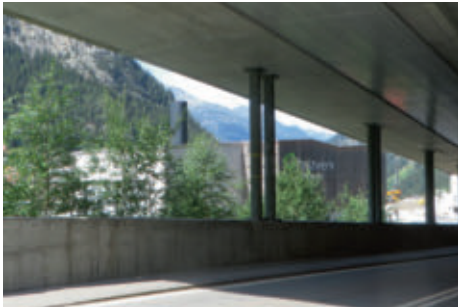
Holzheizwerk der Gotthard AG für die Erzeugung von Fernwärme in Göschenen.
