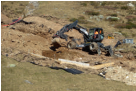
Ein Schreitbagger verlegt Leitungen für Wasser und elektrischen Strom.
