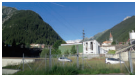
Talstation der militärischen Luftseilbahn Göschenen – Gütsch.
