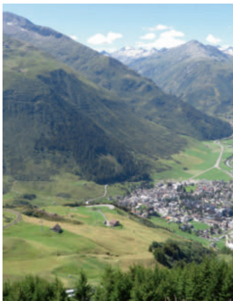
Der Bannwald von Andermatt hat sich seit 1951 erholt und flächenmässig ausgedehnt (Bild von 2015). Oberhalb der Bäume sind die heute verstärkten Lawinverbauungen sichtbar.
