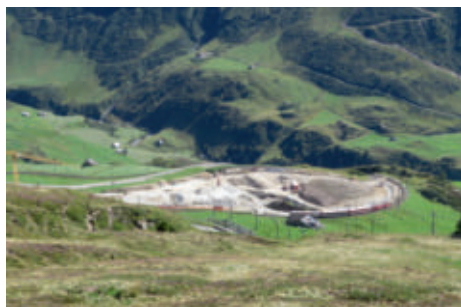
Bauarbeiten zur Umgestaltung des Bahnhofs Nätschen.
