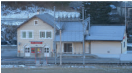
Der Bahnhof von Hospental steht unter Heimatschutz.
