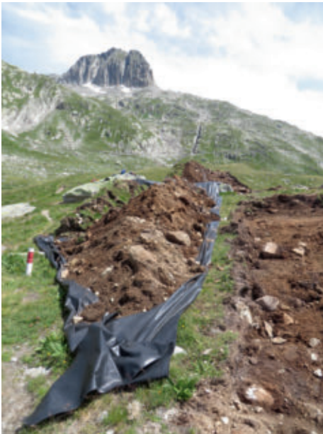
Die Leitungen beim Lutersee wurden nach der Bauphase wieder humusiert.
