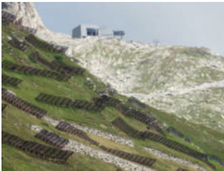
Lawinerverbauungen in der Vorder Felli zwischen Nättschen und Oberalppass.
