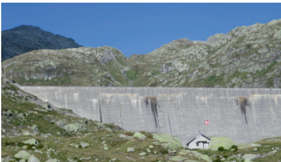
Staumauer des Lucendro-Stausees. Das Urner Wasser fliesst in den Kanton Tessin. Im Jahr 2025 läuft die bestehende Wassernutzungskonzession aus. Sie soll neu vergeben werden. Mit mehr Restwasser?
