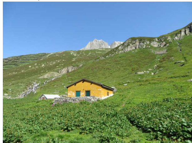
Gebäude, von Blacken umgeben
