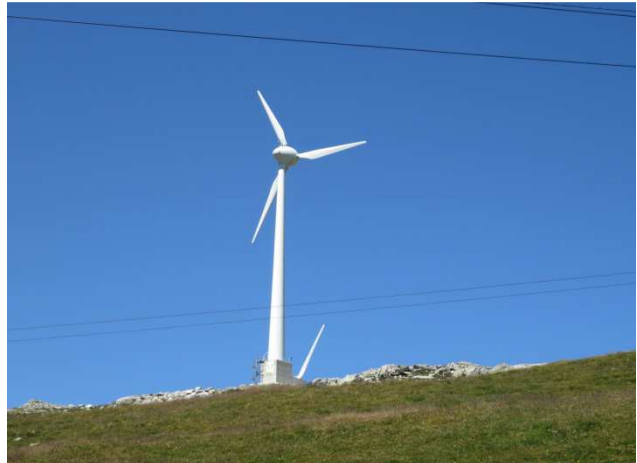
Windpark auf dem Gütsch
