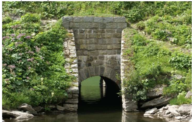
Wasserdurchlass beim Oberalpsee
