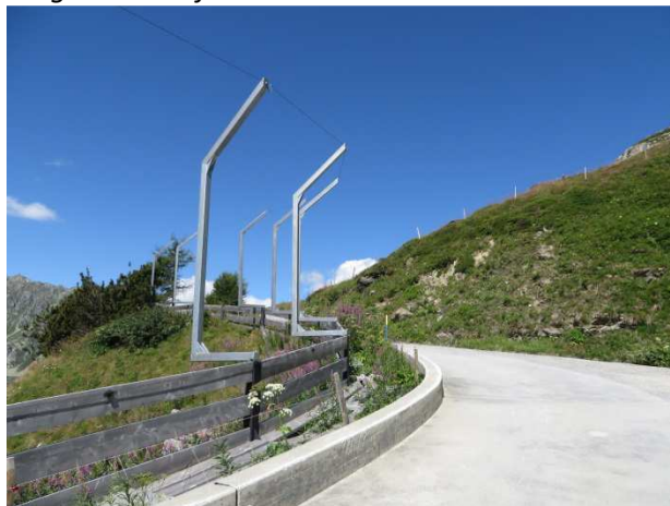
Skipistensicherung am Gütsch
