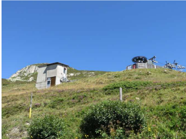
Talstation Sesselbahn Dürstelen - Gütsch
