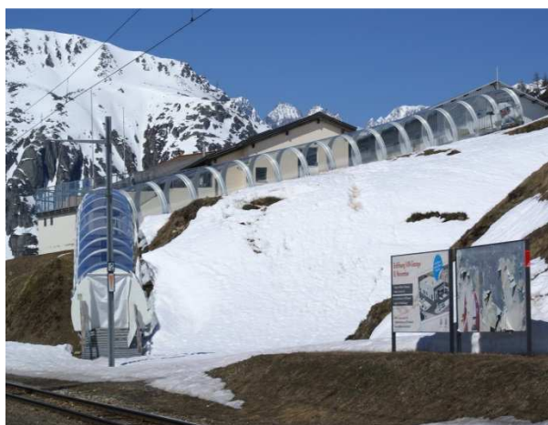
Talstation zum Gütsch beim Bahnhof Nättschen
