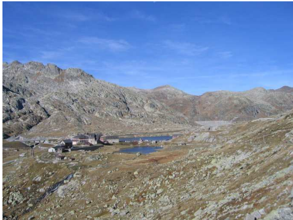
Gotthardpass mit Lucendro-Staumauer
